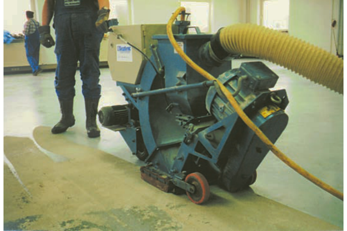
Unterbodenreinigung (Kugelstrahlen, Fräsen, Diamant-Schleifen)
